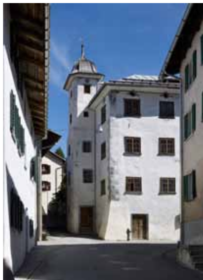
Nach den Konservierungsmaßnahmen: Die Spuren der Zeit sollten am Gebäude sichtbar bleiben. Foto: Ralph Feiner
