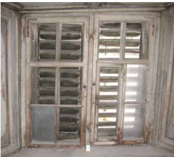
Originalfenster in der unteren Stube im Turalihus vor der Instandsetzung. Durch frühere Setzungen am Haus haben sich die Fensterstock und Blendrahmen trapezförmig verzogen, die Flügel hatten sich herausgedrückt.
