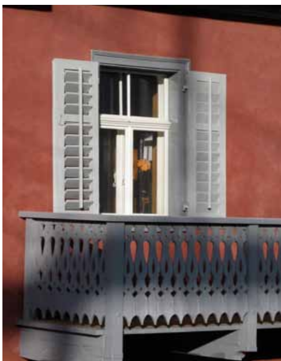
Originalfenster und die hölzernen Fassadenelemente wurden repariert und mit Ölfarbe gestrichen.
