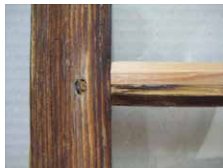
Exakte und materialgerechte Ergänzung einer außenseitig abgewitterten Sprosse mit Glasnut.
