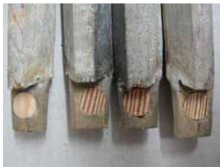
Kleine Reparatur, große Wirkung: Nach Bearbeiten der Querholzdübel bekommen die Holzdübel in den neuen Bohrungen für die nächsten Jahrzehnte wieder einen festen Sitz.
