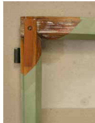
Hilfestellung für den Zimmermann durch den Fensterrestaurator: Am Fensterprofil wurde Holz materialgerecht ergänzt. Die Anstrichabfolge mit Leinölimprägnierung und Leinölfarbe macht den Anstrichaufbau transparent und ablesbar.
